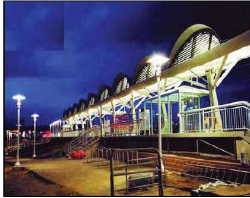
[그림 2.56] UHPC로 시공한 캐나다 캘거리의 경전철역
