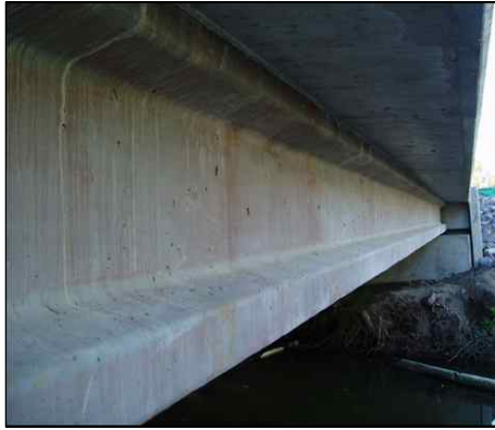
[그림 2.55] Sherlly Creek 교량에 거치된 UHPC I형 거더
