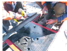
[그림 103] 혹한기에 의한 동결융해 손상 및 보수부 확인
