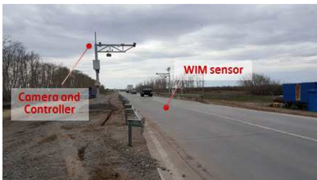
▲ 현지 기설치된 WIM 시스템 전경
