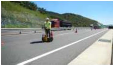
[공정1] 도로 및 포장조사
