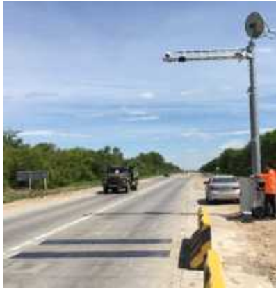
(ㄱ) 테스트베드 현장전경
