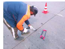
[그림 103] 혹한기에 의한 동결융해 손상 및 보수부 확인
