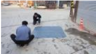
[공정1] 도로 및 포장조사
