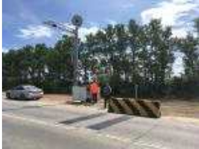
(ㄷ) 테스트베드 현장전경
