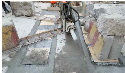
[그림 102] MasterFlow 928 시공사진 예
