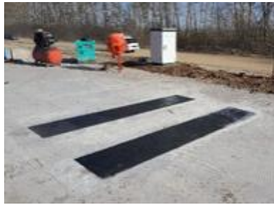
(ㄹ) WIM 센서 플랫폼 시공모습
