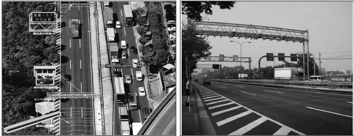
[그림 2.12] 일본의 주행차량 과적단속 시스템
