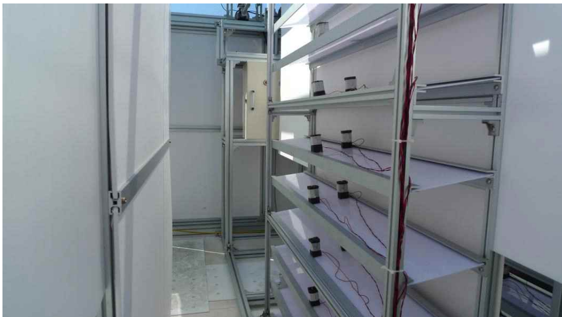
그림 3-2-25. 엔지니어링 테스트베드 CDS 조도센서 모듈 설치
