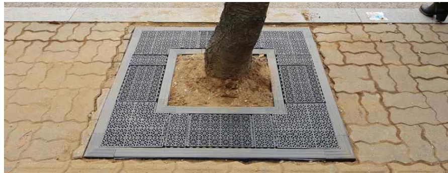
< 그림 3-56 > 2차년도 개발된 가로수 보호판 적용 현장(오산시 궤리사로)
