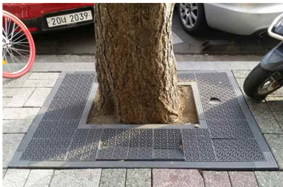
< 그림 1-3 > 기존 제품의 하자 및 유지관리 문제점
