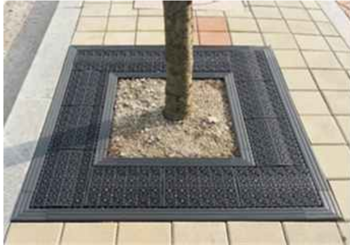
< 그림 3-24 > 개선된 보호판 적용한 가로수 보호판
