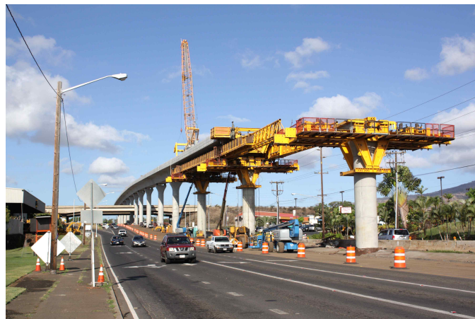
<호놀룰루 경전철 시공(MSS 공법 적용)>
