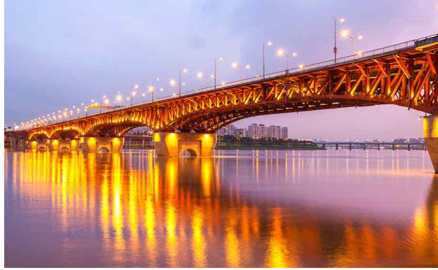
<성수대교 (상부구조: Truss)>
