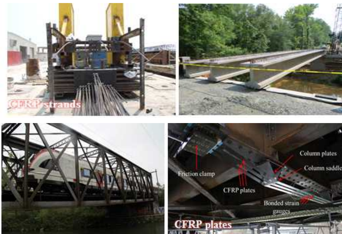
<CFRP strand 및 plate prestressing 적용 사례 (상: 캐나다, 하: 호주)>
