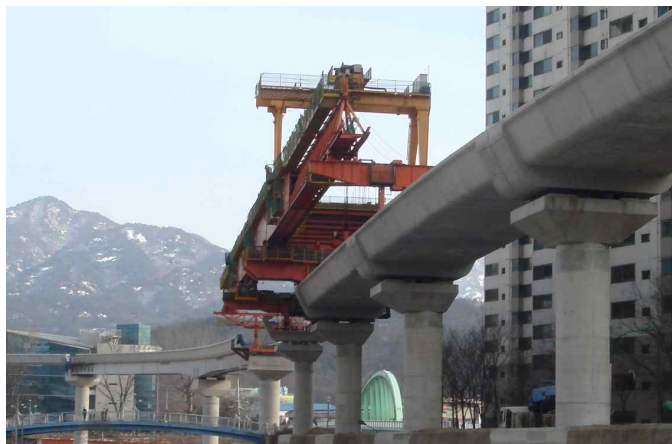
<의정부 경전철 U형 PSC 하로교 시공(PSM 공법 적용)>
