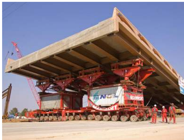
<SPMTs*를 이용한 교량 급속 시공>
