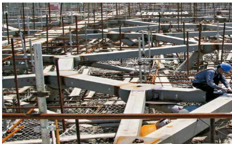
<기존 현장 용접 접합 조립>
