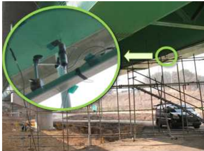
<LVDT를 이용한 고가구조물 변위 계측>
