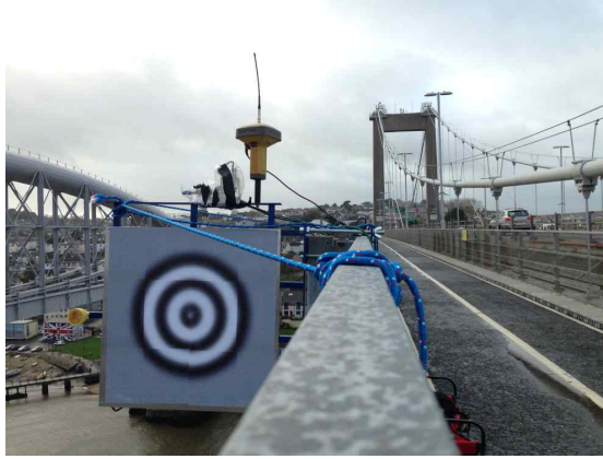
<변위 측정을 위해 교량에 설치된 표적판>
