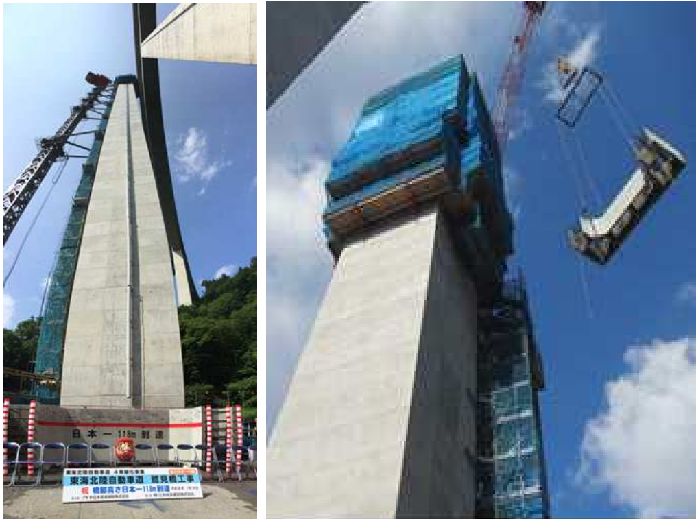
<스미교 공사(교각높이 125m, SPER 공법)>
