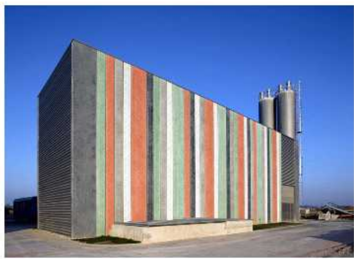
<Graphic Concrete 적용 사례>
