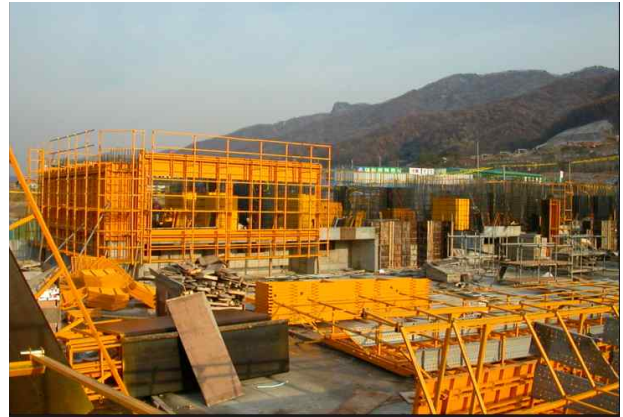
(b)일체식 강제 거푸집(Ganded Steel Form)
