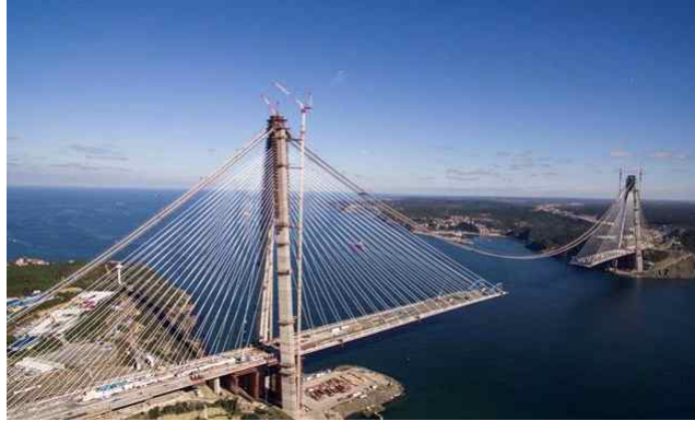
<국내 초장대 도로 교량 기술 (상:이순신 대교, 하:터키 보스포루스 제3대교)>
