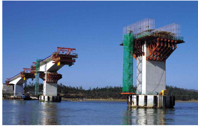
<지도사옥교 PSC Box 시공(FCM 공법 적용)>
