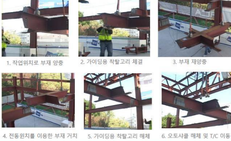
1. 작업위치로 부재 양중 2. 가이딩용 착탈고리 체결 3. 부재 재양중 4. 전동원자를 이용한 부재 거치 5. 가이딩용 착탈고리 해체 6. 오토사를 해체 및 T/C 이동
