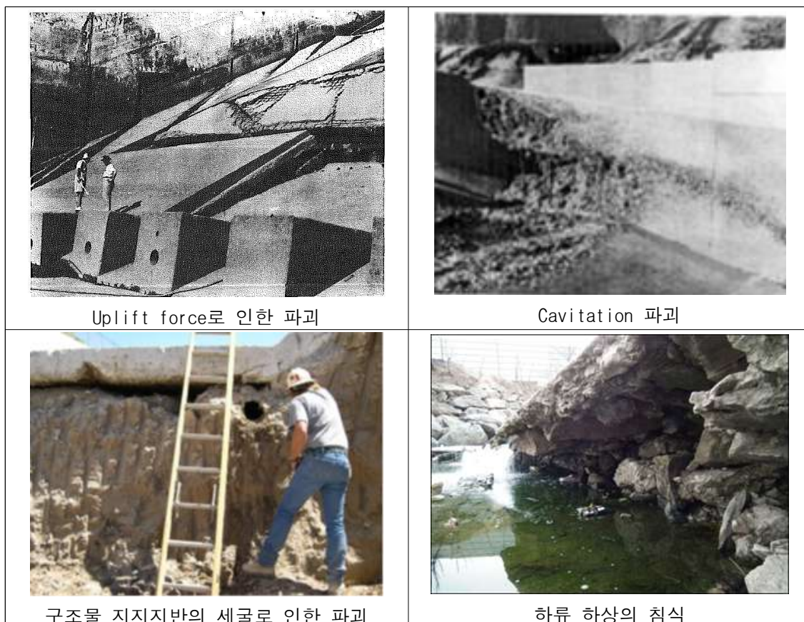
그림 16 구조물 압력변이 작용위치 별 파괴 사례 사진
