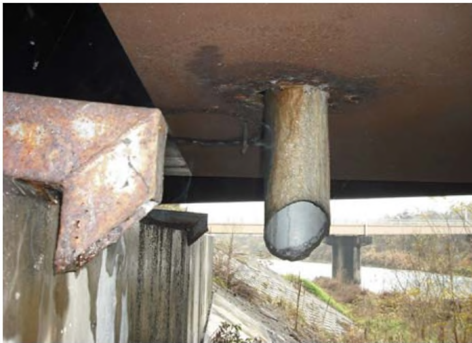
平瀬橋上田市側
