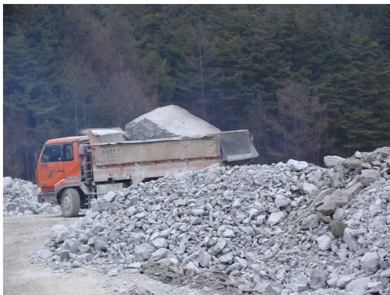
그림 22 암반의 균열에 의한 큰 버력의 발생 예
