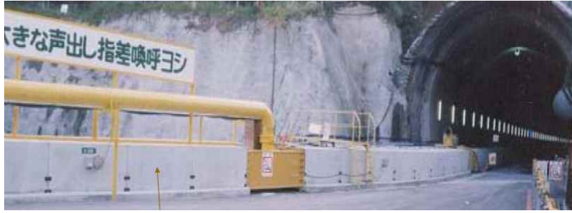
그림 4 터널 공사에 사용된 PCP 장치
