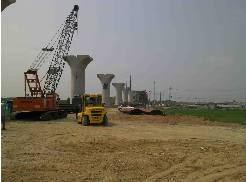
그림 A5.1 지반 평탄화 및 시험부재 하차
