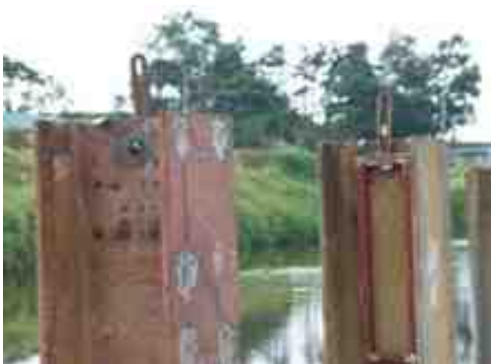
(e) 간격대(항타거치대) 설치
