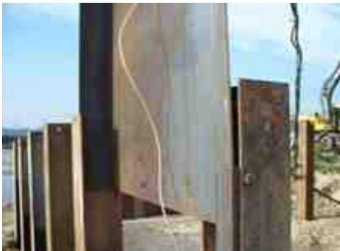
(g) 코너부 Steel Plate 삽입
