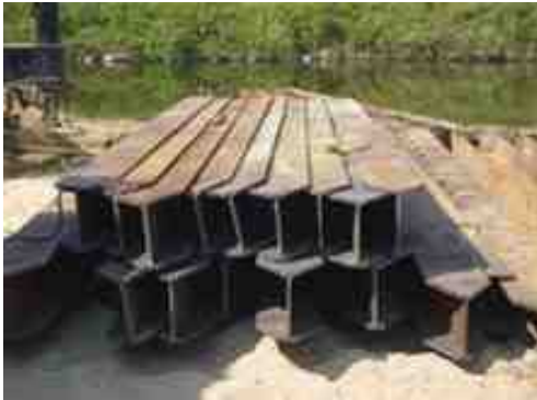
(a) 가이드 H-Pile 제작
