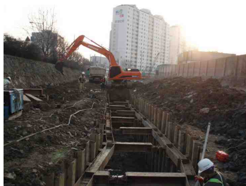
그림 2.3 Sheet-Pile 공법 적용 현장
