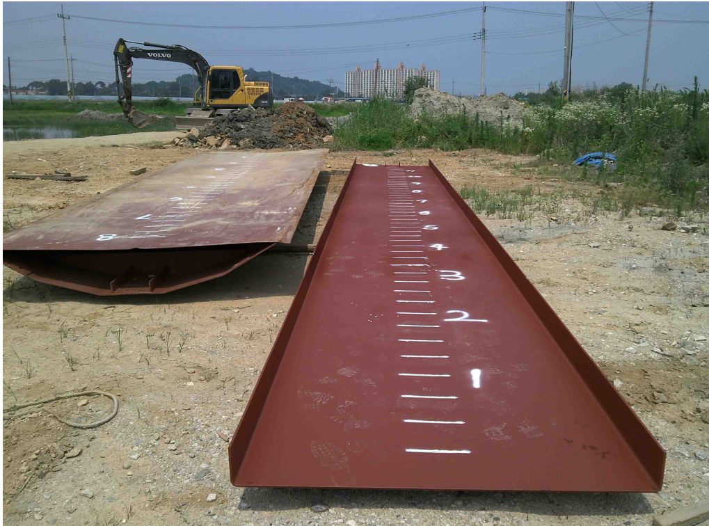
그림 A5.3 부재 현장 적치 및 눈금표시(2)
