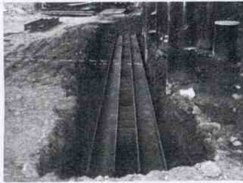
(a) 부지 정리 및 가이드 빔 설치
