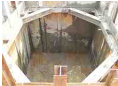
(h) 굴착 및 버팀보 설치
