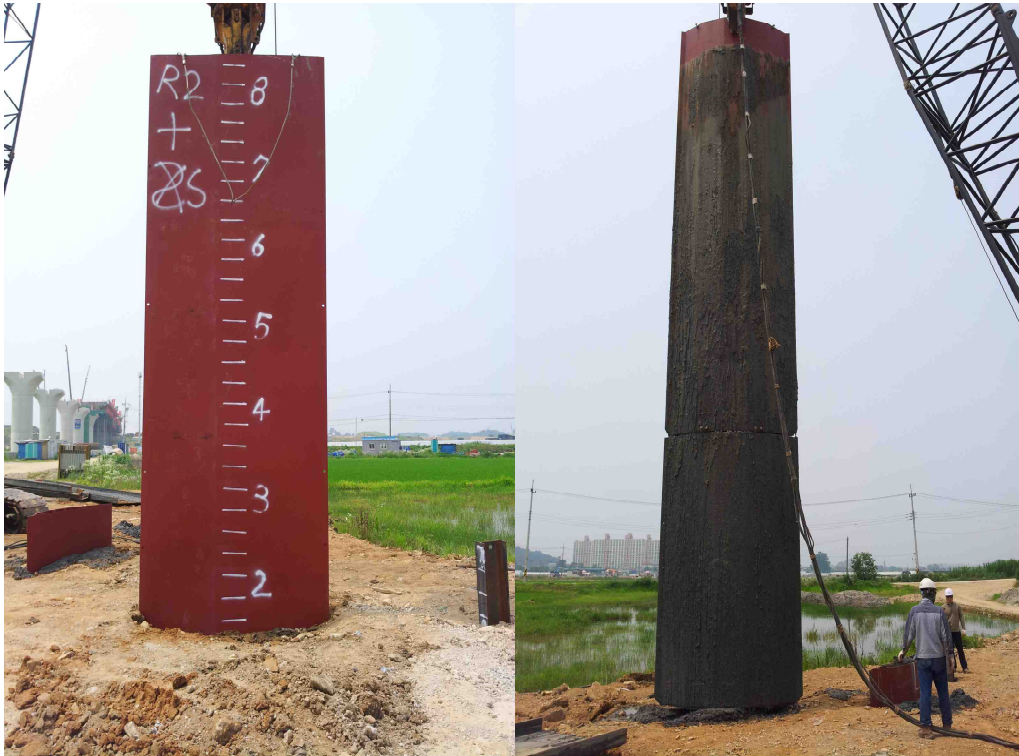
그림 A5.10 아치형 판넬(R2+S) 관입 및 인발
