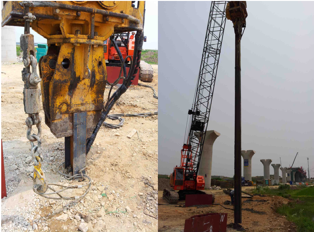
그림 A5.12 H-pile 관입 및 인발
