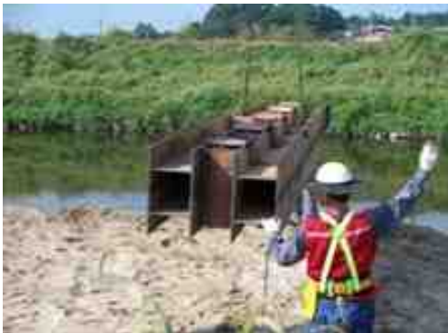
(c) 가이드 빔 설치
