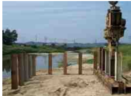
(d) H-Pile 삽입
