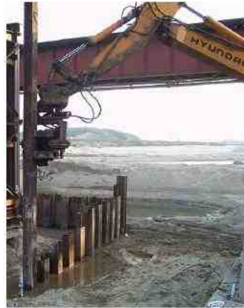
그림 2.2 Sheet-Pile의 삽입 모습
