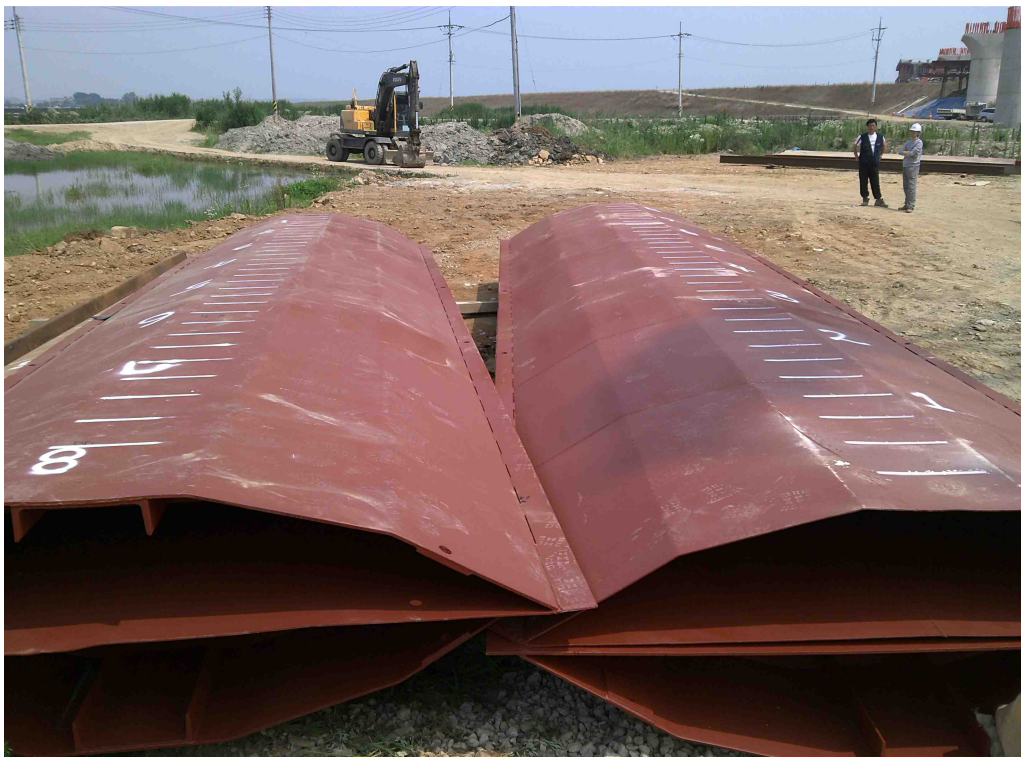
그림 A5.2 부재 현장 적치 및 눈금표시(1)
