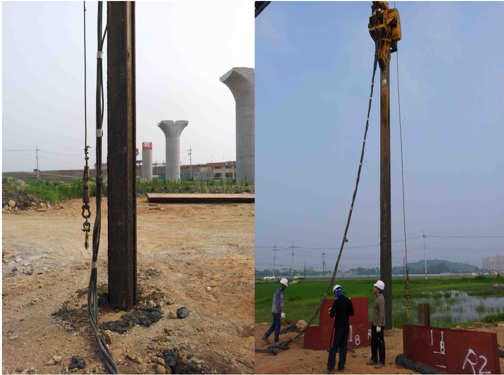
그림 A5.13 Sheet-pile 관입 및 인발
