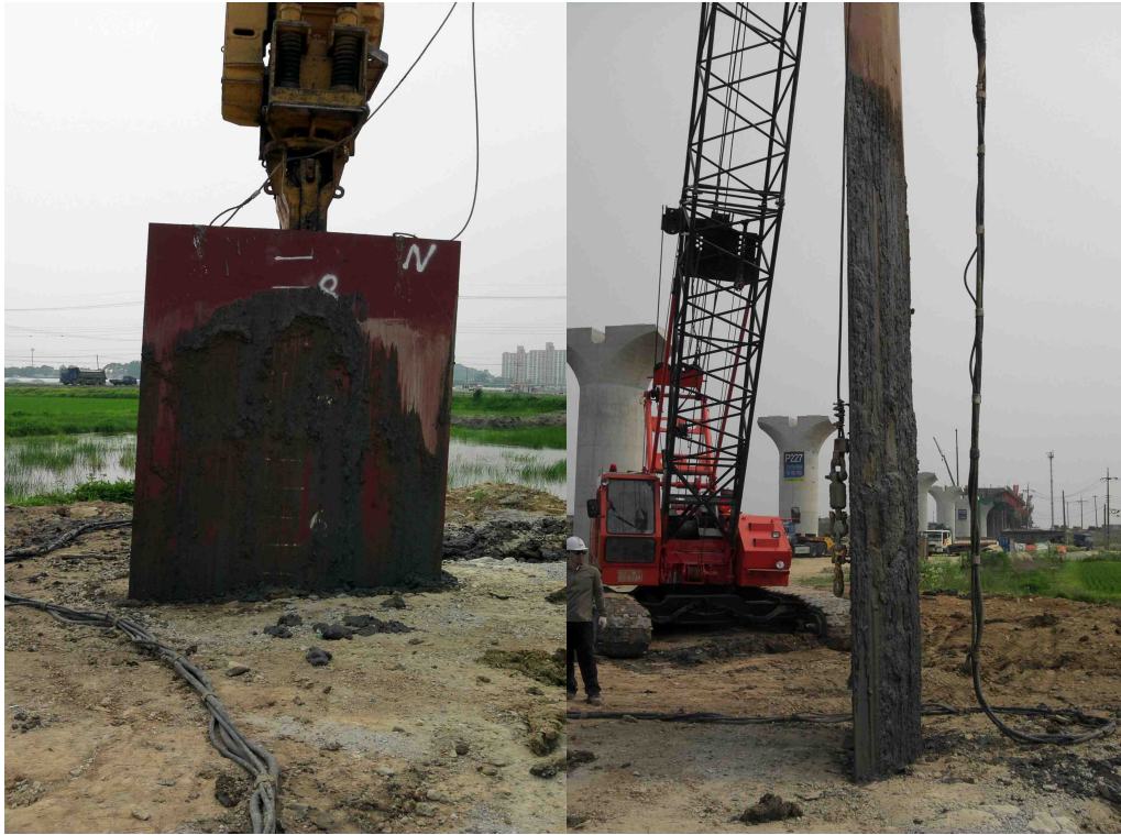
그림 A5.9 아치형 판넬(N) 관입 및 인발
