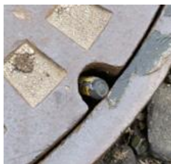
< 맨홀 구멍을 이용한 안테나 노출 방법 >
