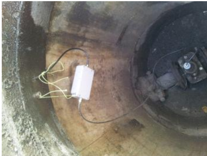
<동두천 상수도 맨홀 시험 설치 화면>
