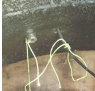
< 맨홀 하부 천공을 이용한 통신 방법 >
