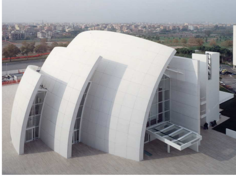
그림 13. 이탈시멘티 광촉매 프리캐스트 패널 공법 (좌: 로마 다비스 성당, 우: 프랑스 국립드라마 극장, http://www.italcementigroup.com )
