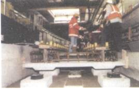
<플로팅 궤도시스템의 부설 및 경부고속철도에 설치된 플로팅 슬래브>
