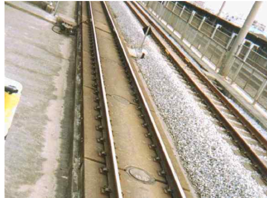
<일본 프리캐스트 콘크리트 슬래브궤도(J-Slab)>
