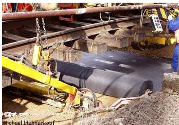
그림 3.4-3. 토목섬유 자동 설치 모듈
