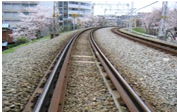
그림 2.4-7. Ladder Track System 부설 전경
