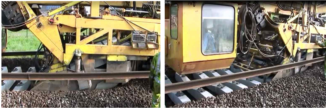
그림 3.4-1 침목 자동 교환 장비를 이용한 침목 교환 작업(미국 Hasco 社)
