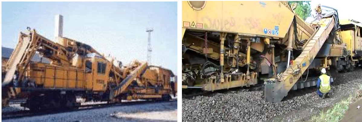
그림 3.4-2. 발라스트 클리너를 이용한 자갈 교환 작업
