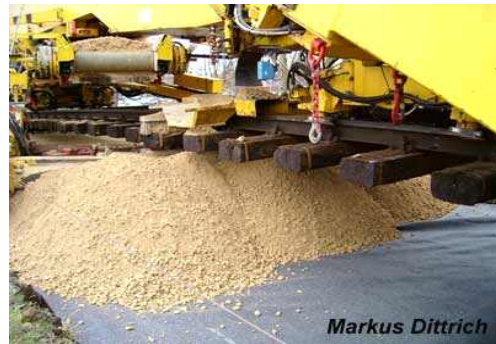
(b) 토목섬유 및 강화노반 설치
