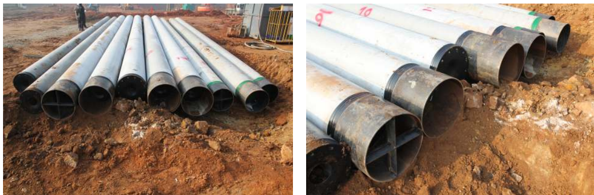
그림 2.1 시험말뚝에 사용된 PHC 및 강관 부착 PHC파일
