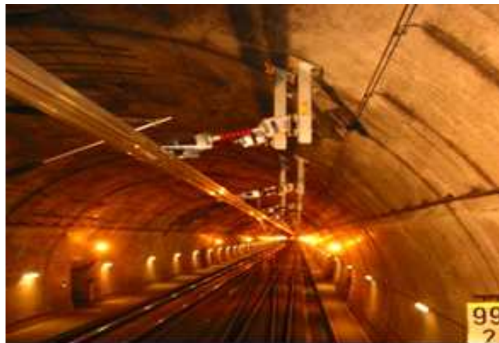
<오스트리아의 R-bar 설치 현장>
