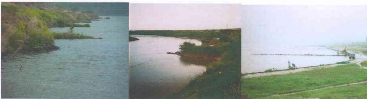
<그림2> 낙동강 하류(좌측), 영산강 하류(중간), 형산강 하류(우측)에 설치된 수제
