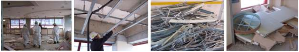
[그림 2-22] 철근콘크리트조(RC) 및 조적조 건축물 철거현장
