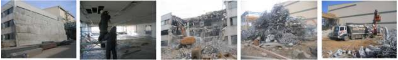
[그림 2-21] 철골철근콘크리트(SRC)조 건축물 철거현장
