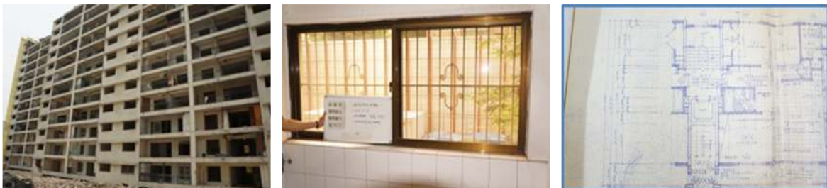
[그림 2-20] 잠원 대림 아파트 재건축/철거현장 도면 및 사진
