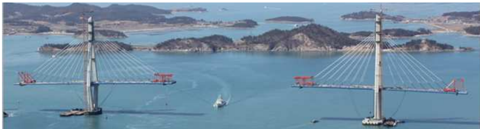
그림 2.17 FCM 공법으로 시공되는 사장교 예
