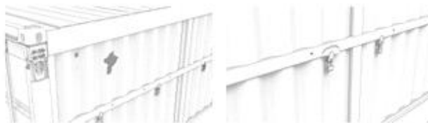
힌지와 슬라이딩 조인트의 돌김과 손상, 녹발생여부 측벽 지지용 멤버와 각재들의 정위치와 상태, 탭너트와 와셔등의 잠금상태
