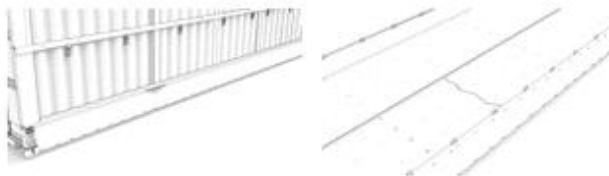
하부 모서리쇠 정렬 / 하부 레일의 휨과 손상 / 갈라짐 오염과 악취
