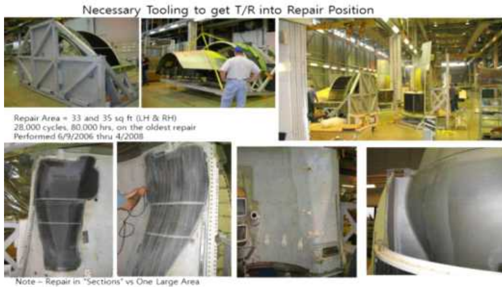
그림 47. 전형적인 엔진 역추진장치 정밀 수리 Jig Fixture 예 - Bonded Repair Service Provider-Service History and Substantiation
