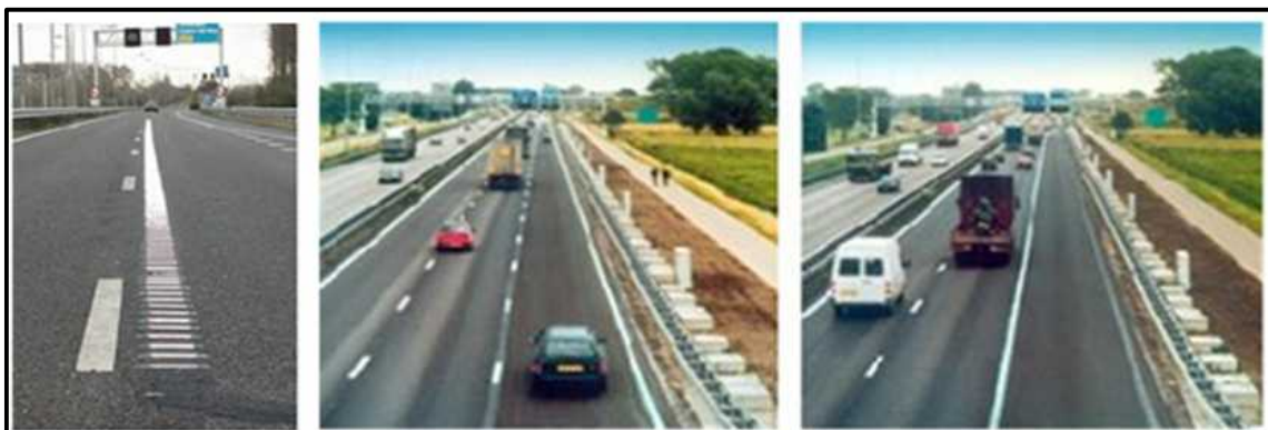
<그림 4-6> 네덜란드, 독일 등 유럽에서 사용되는 DRM(Dynamic Road Marking)
