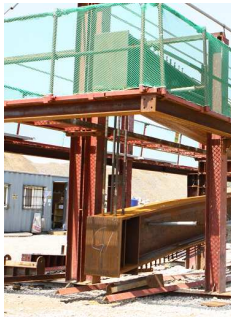
(a) 거더 설치
