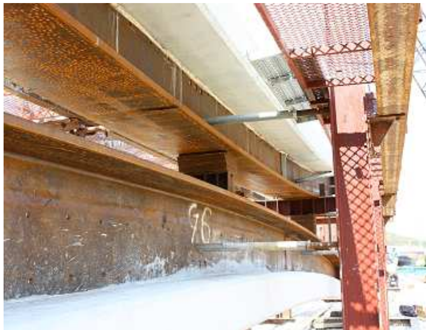
<5점 프리플렉션 하중도입 후 고정지그를 이용한 하중유지>
