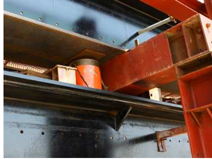
(b) 유압잭 설치
