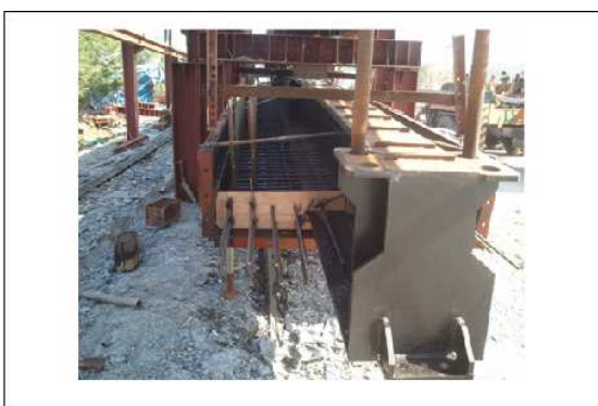
㉣ 거푸집 조립 및 콘크리트 품질검사
