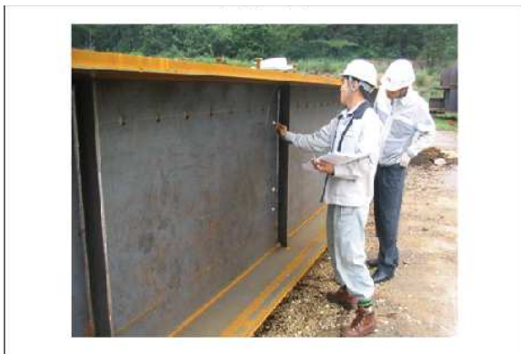
㉗ 최종 검사 및 하부플랜지 구체 콘크리트 타설을 위한 운송
