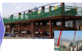
<거푸집 설치 및 콘크리트 타설>
