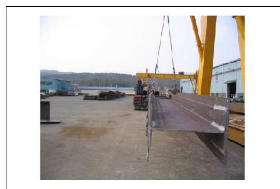
㉗ 최종 검사 및 하부플랜지 구체 콘크리트 타설을 위한 운송
