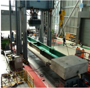
<15m 2-거더 시험체 설치>
