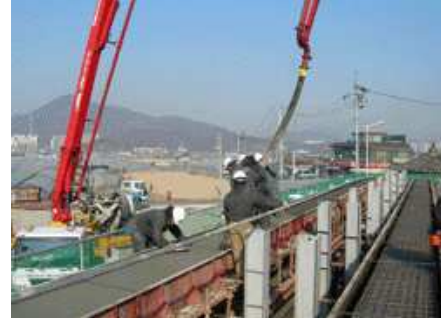
(c) 케이싱 콘크리트 타설
