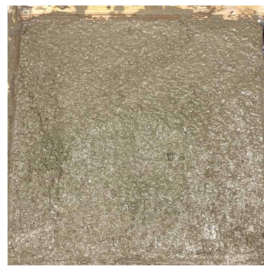
(b) 일반 콘크리트 타설 후
