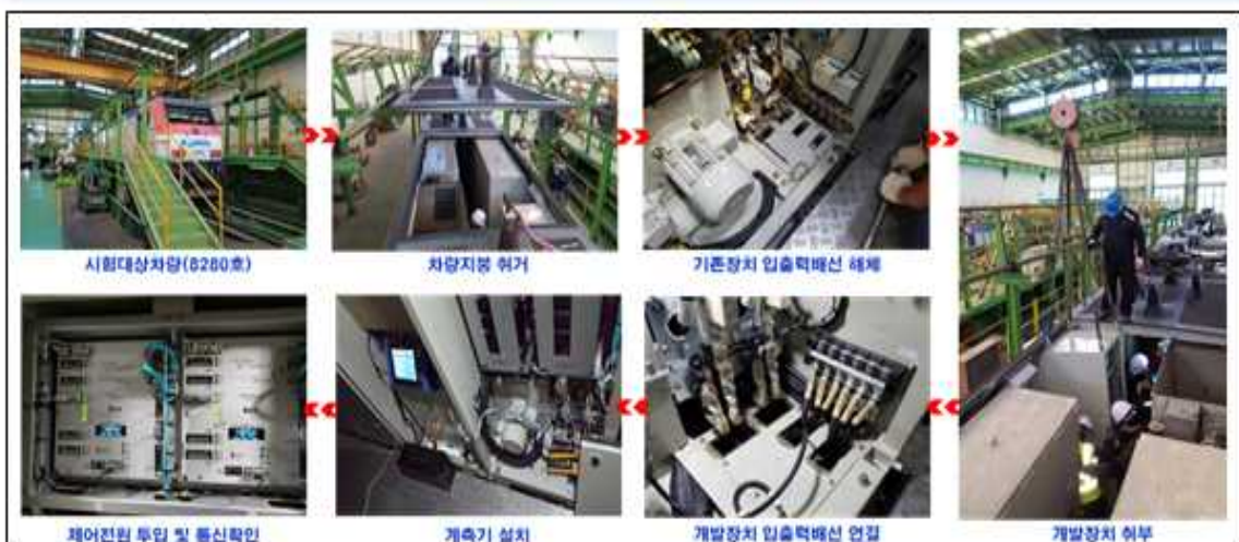
그림 66. 개발품 현차 설치 및 시험
