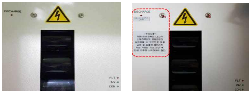
그림 76. 방전램프 설치 및 작업 안전표지 부착
