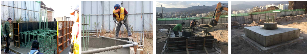
그림 3.5 콘크리트타설 및 양생
