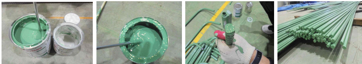
그림 3.3 손상부 에폭시 보수
