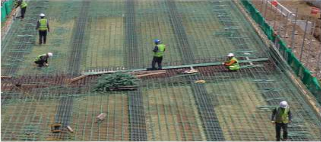
사진설명(5)에폭시 피복철근 조립 및 아연도금 결속선 결속
