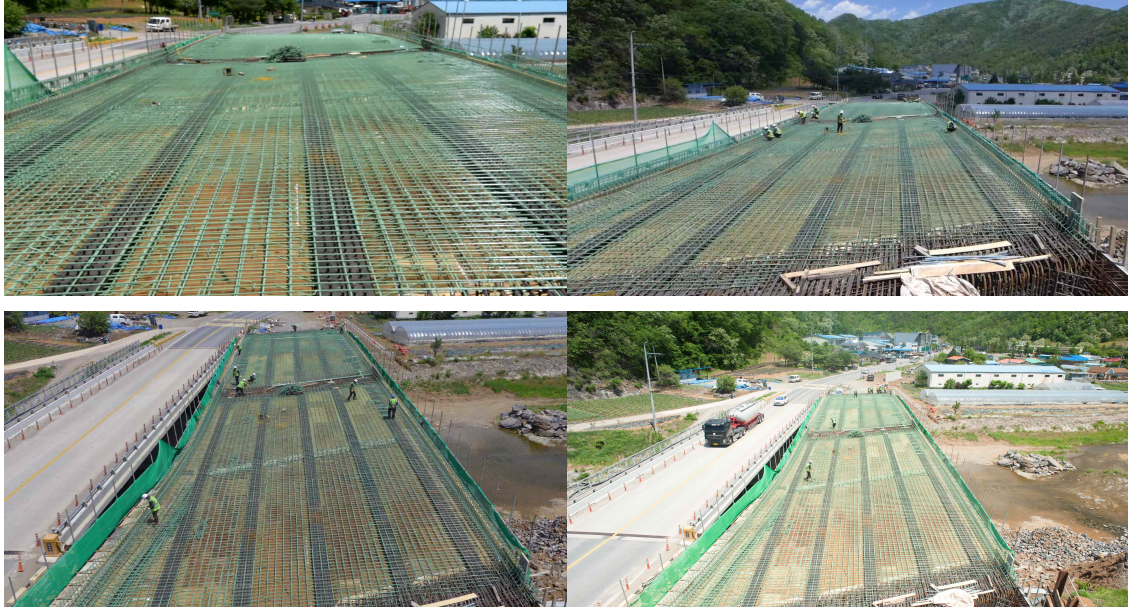
그림 3.13 간포교 상부슬래브 철근배근 전경
