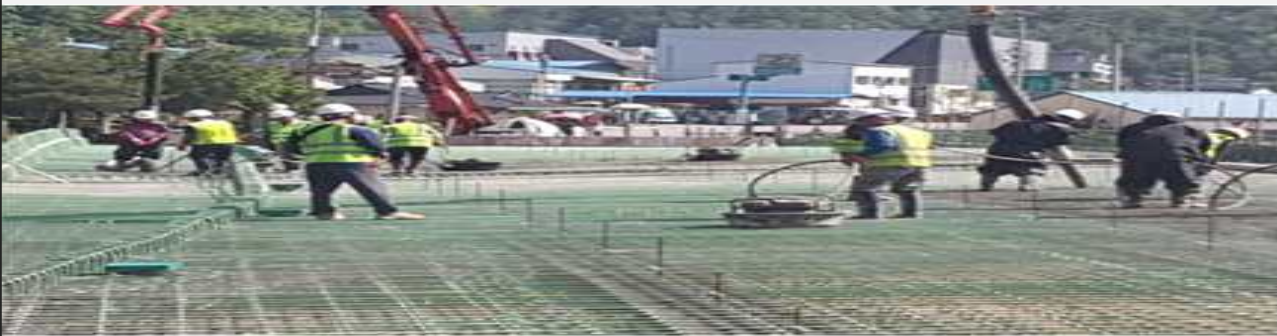
사진설명(8)/ 콘크리트 타설
