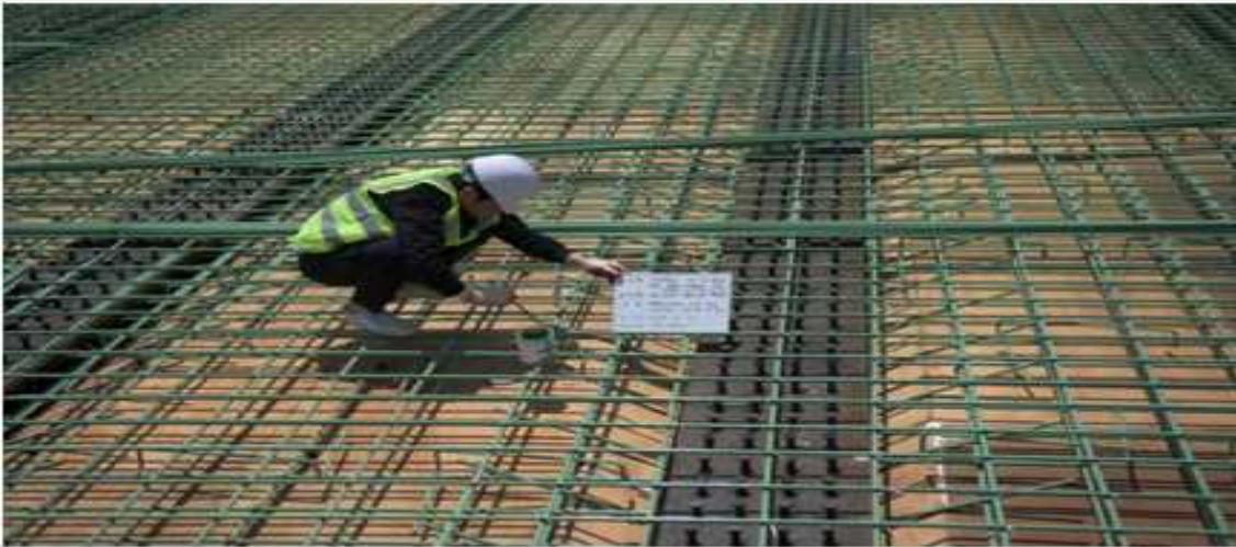
사진설명(6)/ 에폭시 피복철근 가공시 절단부 및 훼손부 보수
