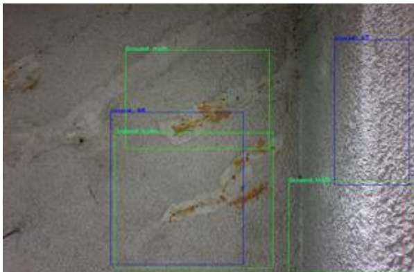
그림 2-79 Class4(누수흔적) 하자 감지가 잘되지 않은 예1
