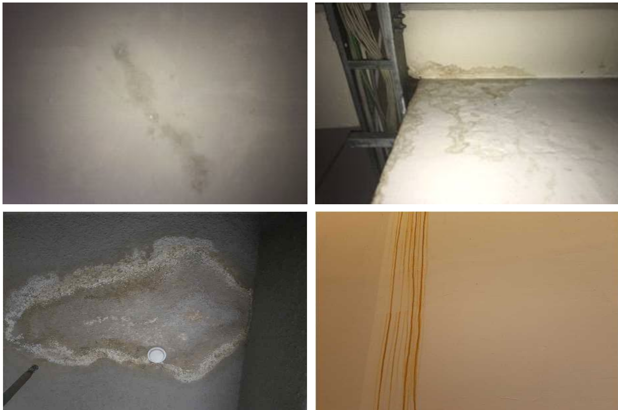
그림 2-14. 1차년도 누수흔적 데이터 예시
