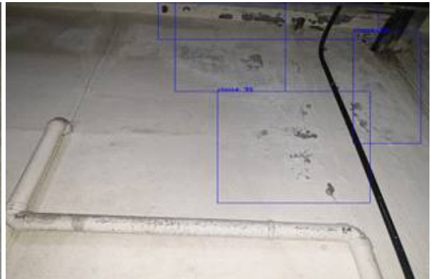
그림 2-78. Class4(누수흔적) 하자 감지가 잘된 예6
