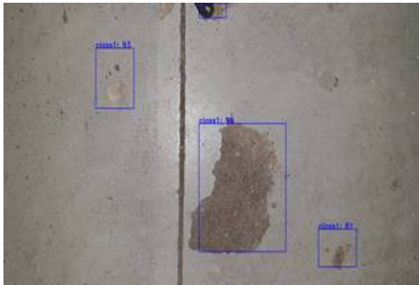
그림 2-61. Class1(도장박리) 하자 감지가 잘된 예5
