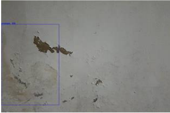
그림 2-73 Class4(누수흔적) 하자 감지가 잘된 예1
