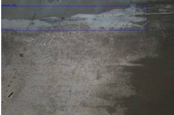
그림 2-75. Class4(누수흔적) 하자 감지가 잘된 예3
