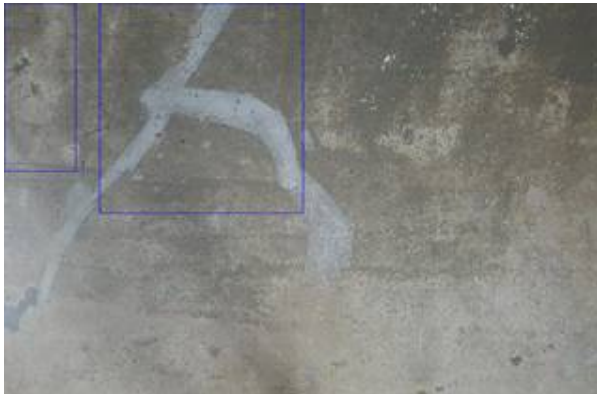
그림 2-77. Class4(누수흔적) 하자 감지가 잘된 예5
