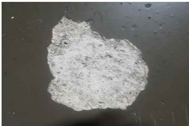
그림 2-16. 1차년도 도장박리 데이터 예시
