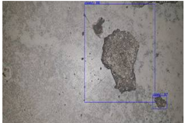
그림 2-60. Class1(도장박리) 하자 감지가 잘된 예4
