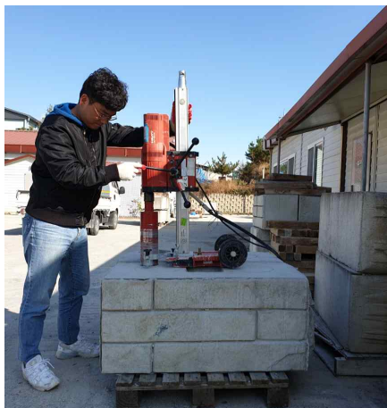
[그림 2.55] 콘크리트 코어링
