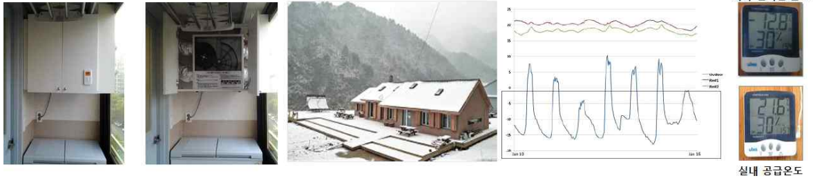
입상식 회전식 열회수환기장치 설치 (아파트), 홍천 살둔 제로에너지 하우스 적용 및 성능
