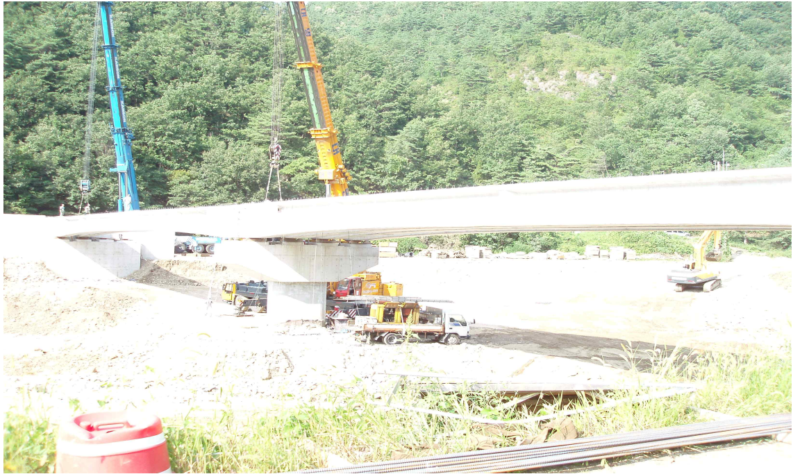
[어천제축조공사, 월통교 2@42=84m]
