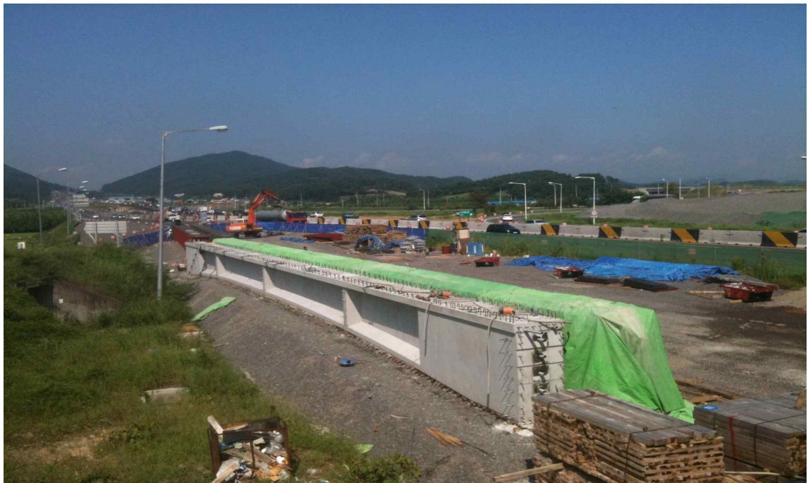
[진주-마산 6공구, 도항교 3@40=120m]
