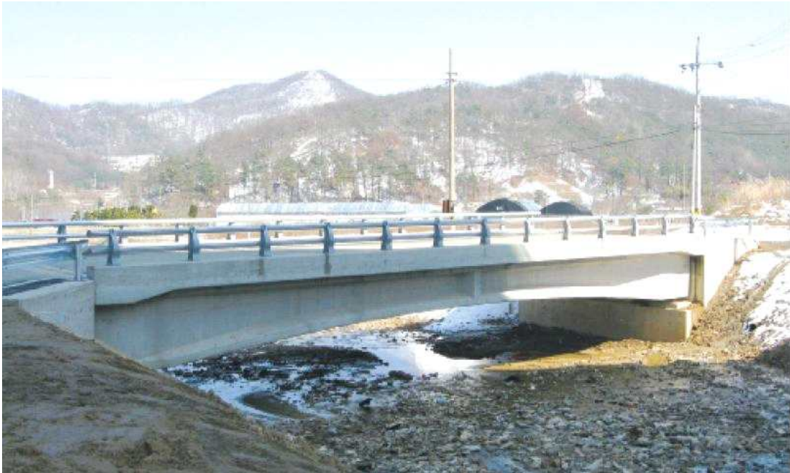
[대전-당진간 1공구, 산곡천교 1@25=25m]
