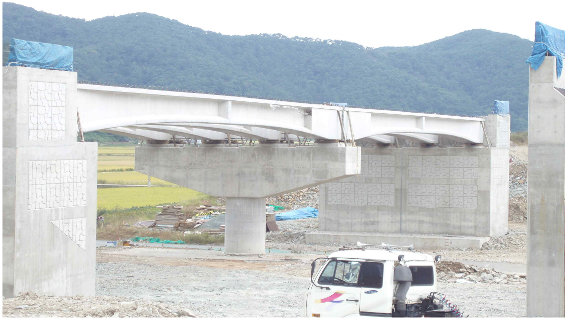
[본덕-임곡간 도로개설공사, 봉흥2교 2@30=60m]
