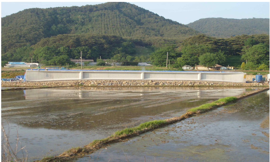
[고풍교우회도로 건설공사, 용장교 7@43=301m]
