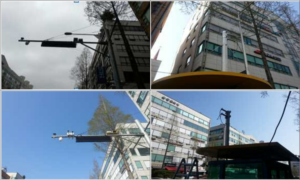
(그림. 209) 주차정보수집장비 설치
