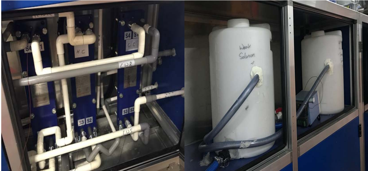
그림 57. 프로토타입 패키지 유닛 제습수용액 배관 및 탱크
