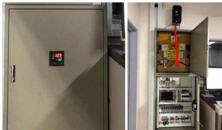
그림 135. PID 온도제어기와 히트펌프 압축기 인버터 제어기 연동
