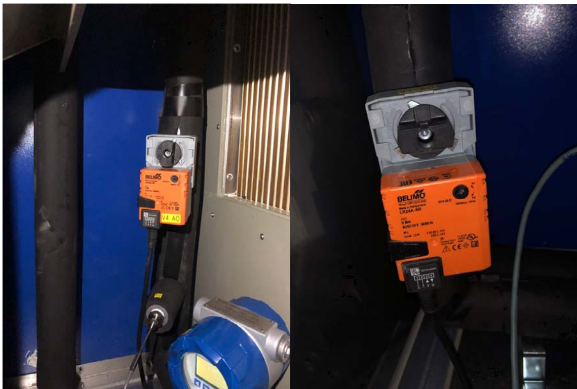
그림 124. 제습수용액 공급 유량 제어를 위한 전자식 비례제어 밸브 구축 사례
