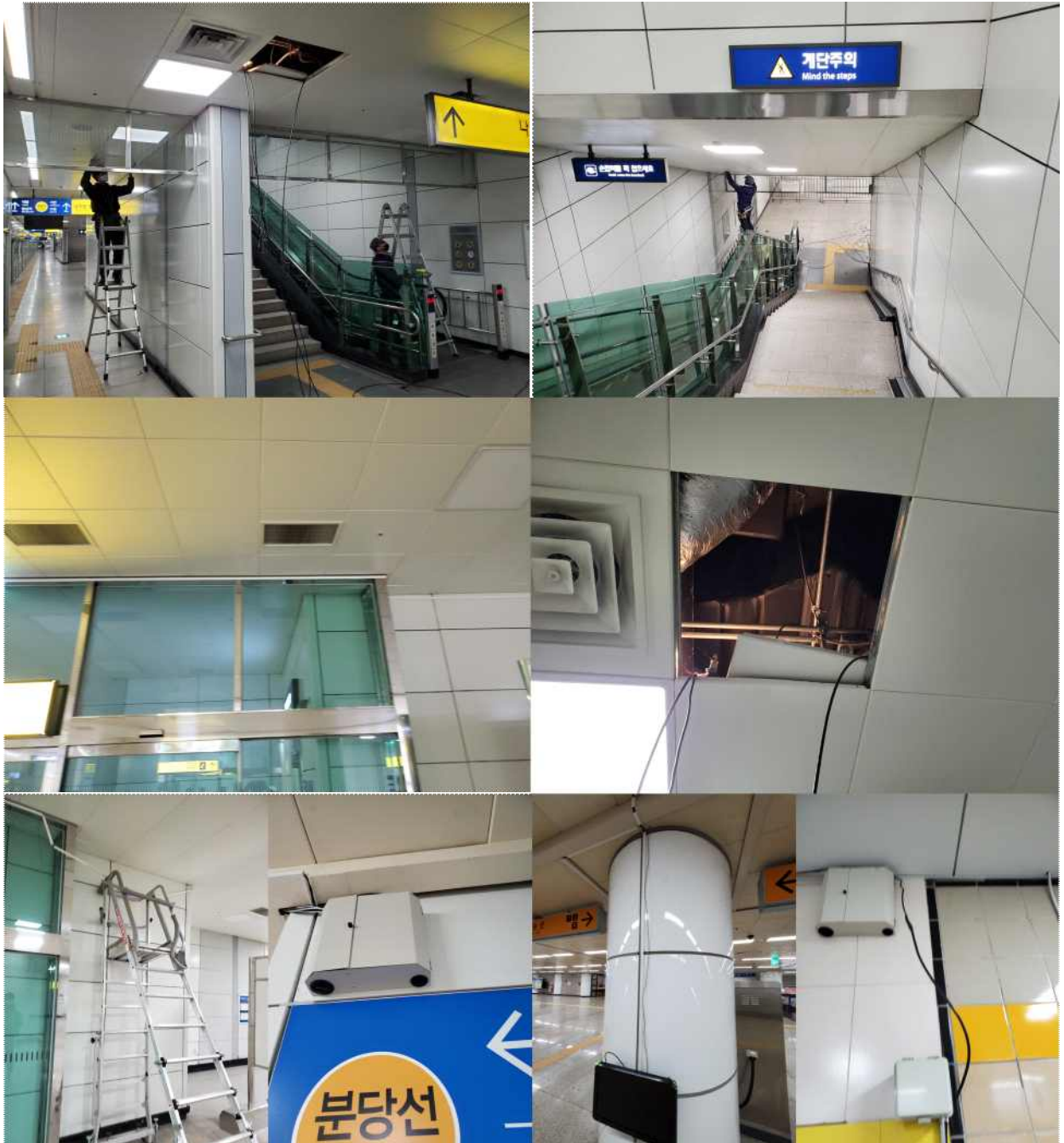
그림 63. 이매역 유/무선 공사
