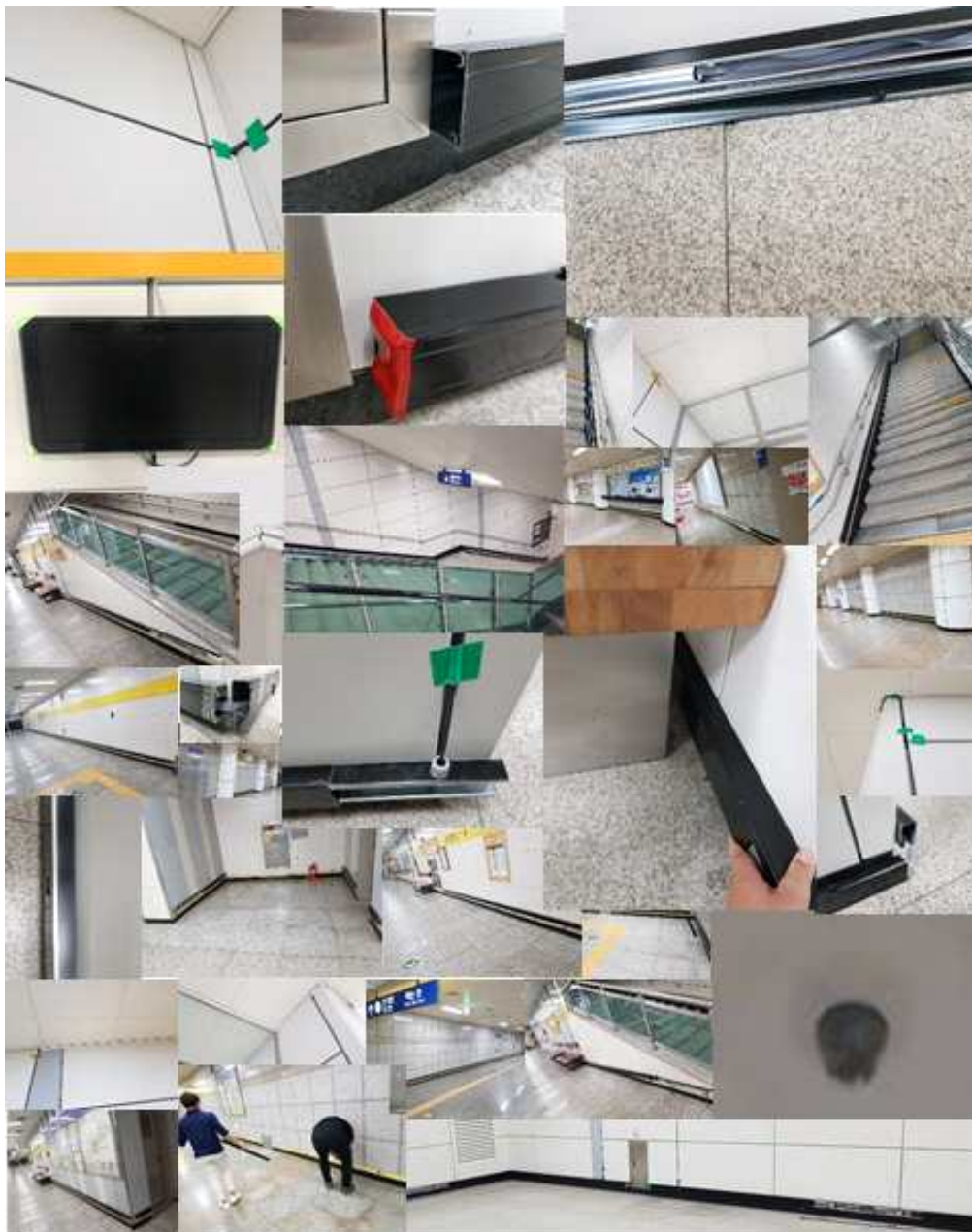
그림 60. 이매역 테스트베드 설치 공사
