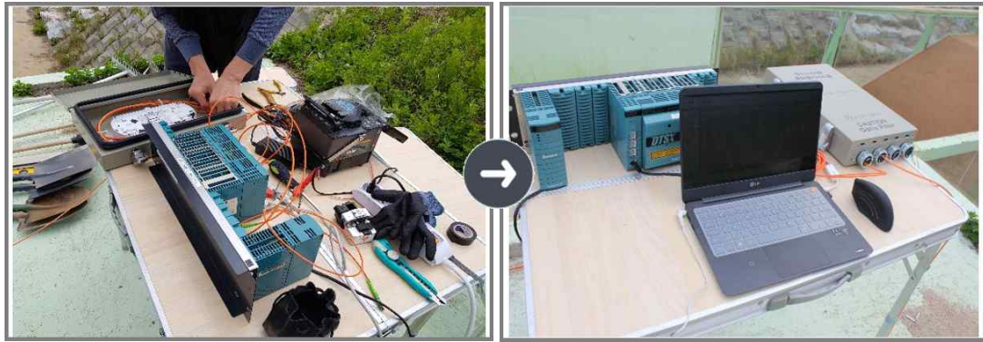
그림 2.2.3. 광섬유 분포형 온도 모니터링 시스템(DTS) 연결 및 설치
