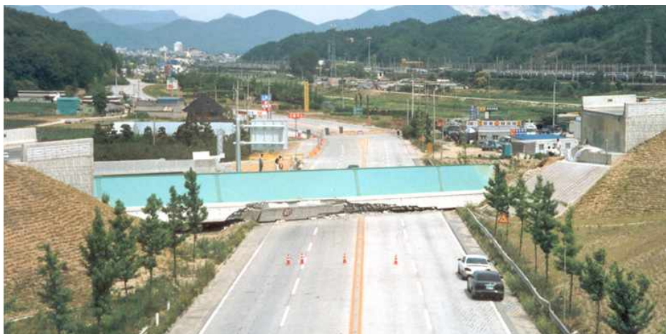
그림1.1.3 제천-신동 IC 곡선 교량의 낙교사고
