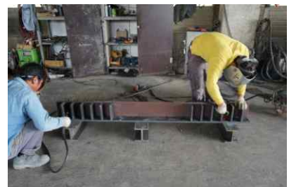
다이아프램 설치 및 용접
