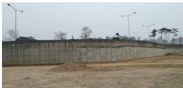
그림4.3.1 태릉 구리간 고속화도로 램프구간 보수
