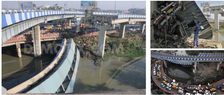
그림2.18.1 인도, Kolkata의 차량 충돌에 의한 낙교 사고사례(2013.03.03.)
