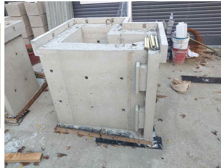
콘크리트 구조체 제작
