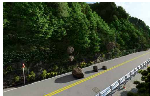
(f) 암석 탈락 모델링(암석 탈락 속도/위치 등)
