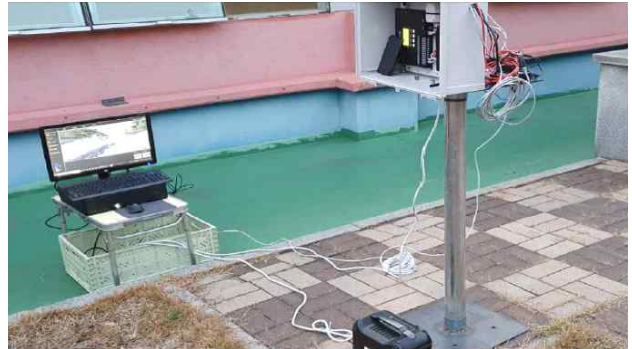
(e) 현장 기기와 검증시험 대상제품 연결 사진
