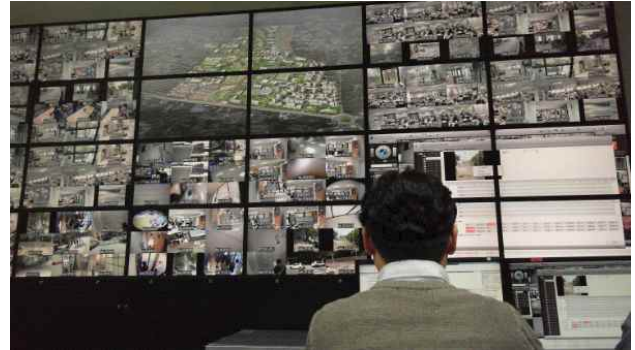
(b) 보안서비스기업 CCTV 관제센터 사례
