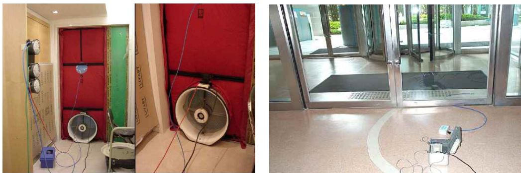
[그림 1-13] 건물 기밀도 및 압력차 측정
