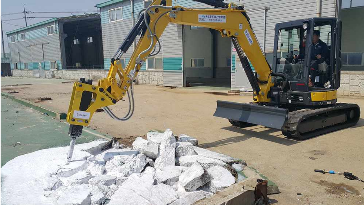
<그림 44> 브레이커를 사용한 거품분사 해체작업
