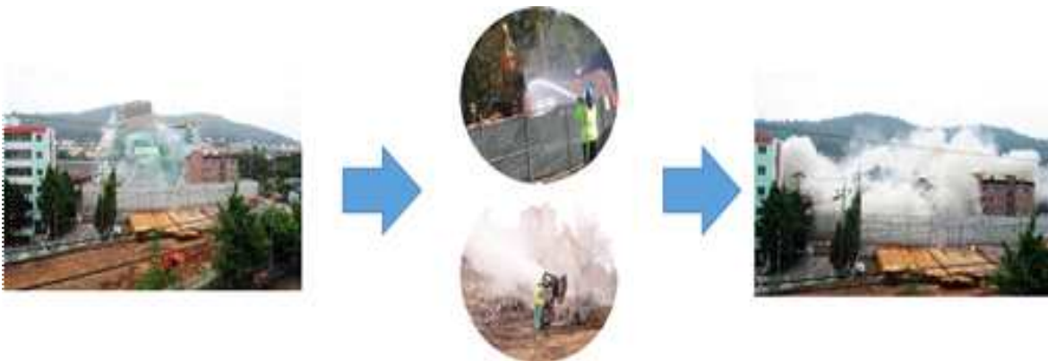
<그림 1> 기존 공법의 분진이 발생하는 모습
