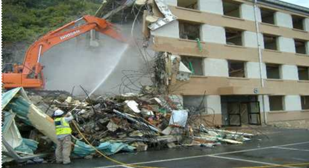
<그림 2> 살수작업 시 비산하는 분진 모습
