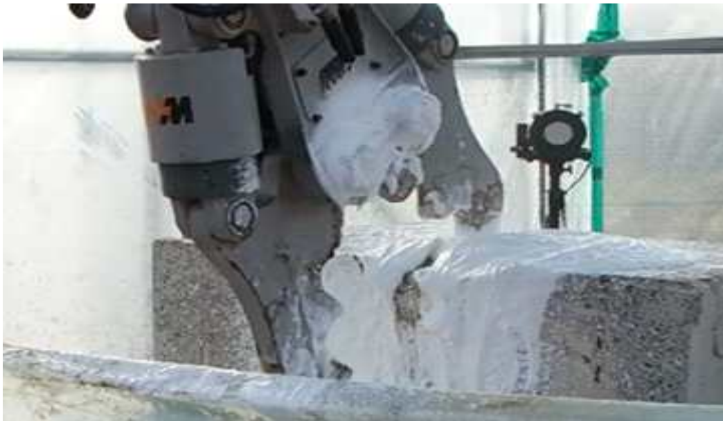
<그림 57> 거품해체공법을 적용한 실험부재 파쇄작업
