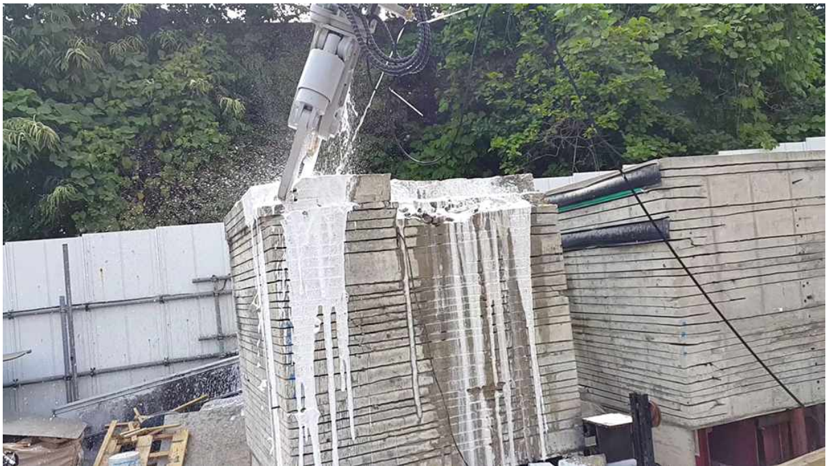
<그림 29> 압쇄기로 콘크리트 파쇄하며 거품 분사 테스트
