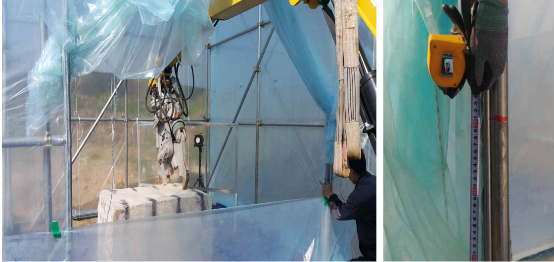
<그림 54> 가시설물 비닐 가림막 설치 현황
