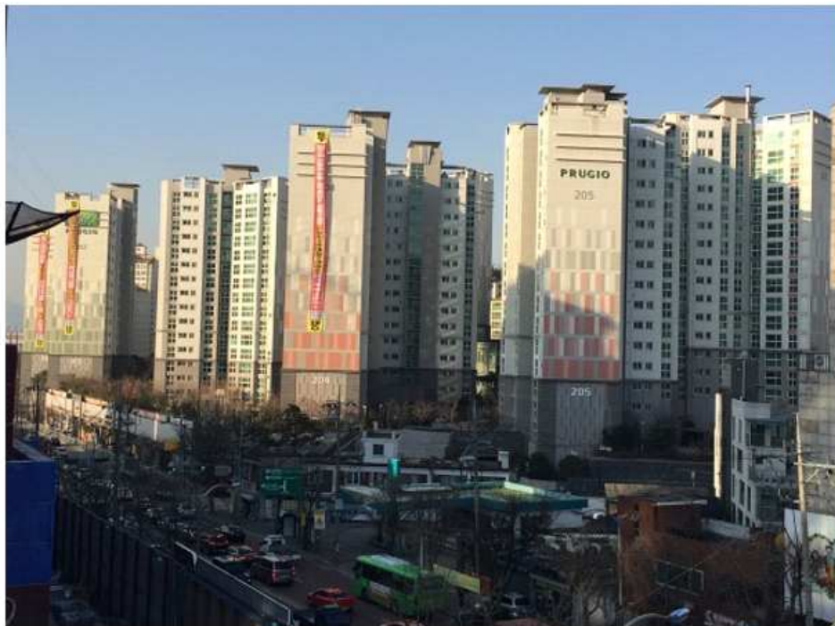
▲ 내년 2월 완공을 목전에 둔 '힐스테이트금호아파트'가 일조권과 조망권 침해 논란에 휩싸였다. 맞은편에 위치한 서울숲푸르지오2차(사진) 입주주민들은 현대건설 측에 강력히 항의하고 있지만 시공을 맡은 현대건설 측은 소음과 분진 등에 관한 피해보상안을 제안하는 것 외에 이렇다 할 해결책을 찾지 못하고 있다. ©스카이드ेल리
