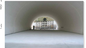
<기존 40m 터널 내부 전경>
