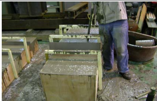
(7) 콘크리트 타설 후 진동다짐
