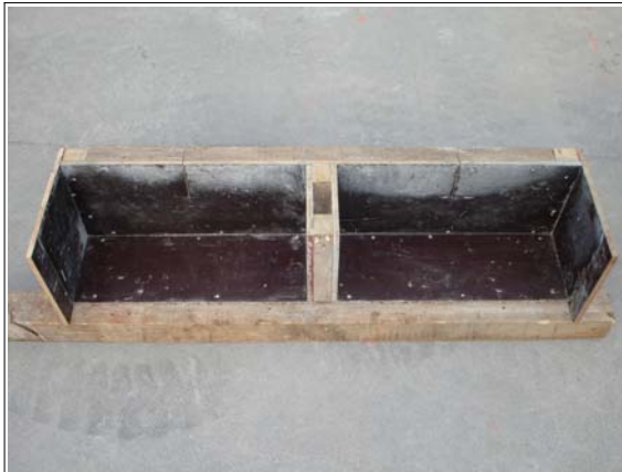
콘크리트 거푸집 제작
