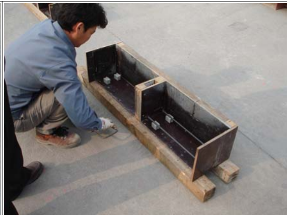
스페이서 설치 및 철근 배근
