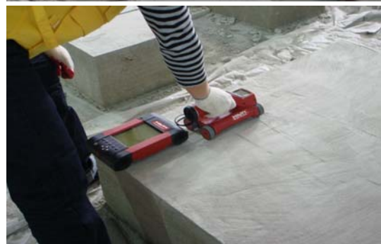
철근탐사기를 이용한 철근 배근 검사
