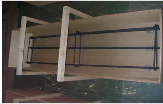
(3) 시편변형 제어철근 설치
