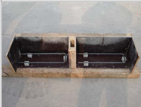
철근 배근 완료된 시험체
