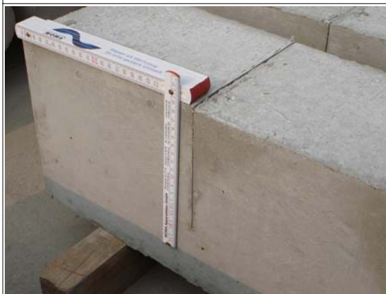
소형시험체 균열깊이 치수확인
