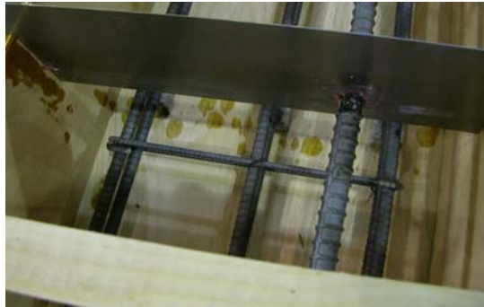
(5) 균열유도판 설치 후 오일도포
