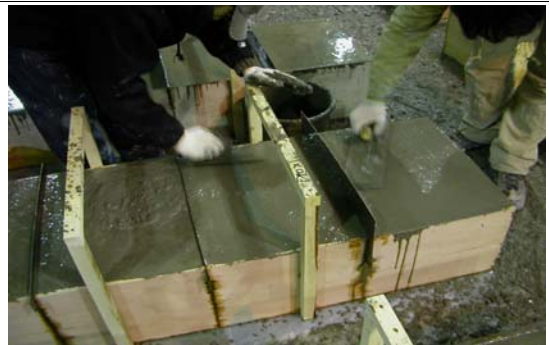
(8) 콘크리트 표면 마무리
