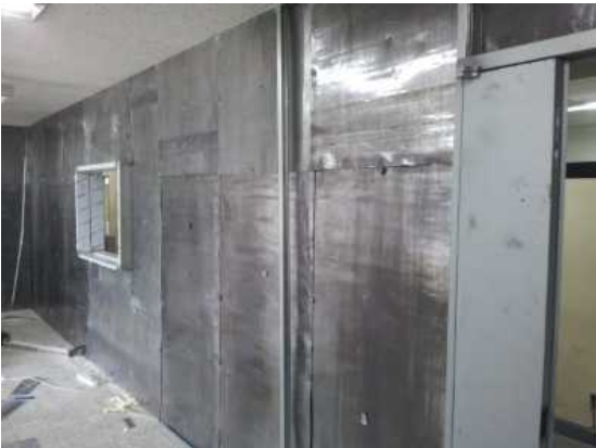
<그림 4.1> 납 판 시공 (예시)
