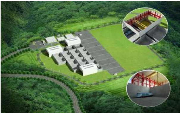
<그림 5.1> 표층 처분 시설 모식도 (출처: 한국원자력환경공단)
