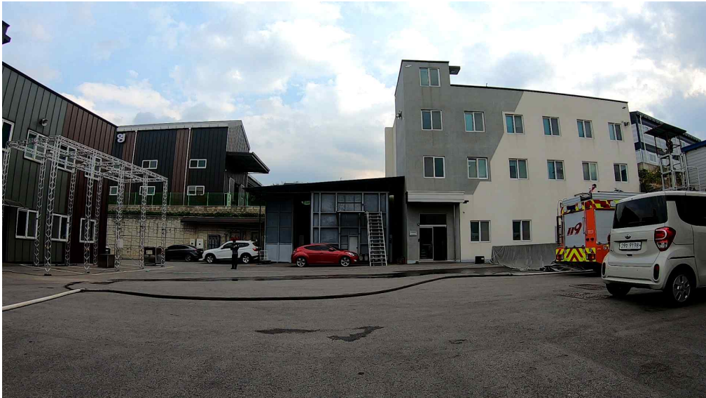
Fig. 3.4.17 화재 발화위치추적 자동소화시스템 방사거리 30M 측면
