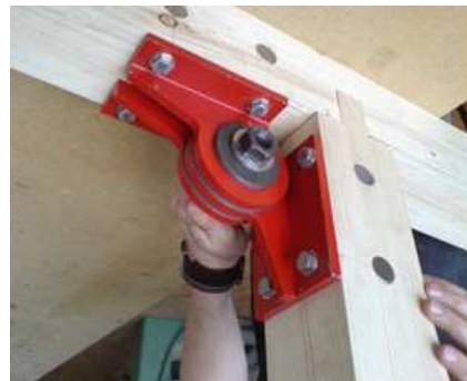
(b) 접합부 댐퍼 설치
