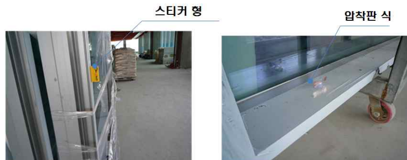
<그림 3-101> 커튼월 공장 및 현장 테스트를 위한 RFID tag 부착 위치
