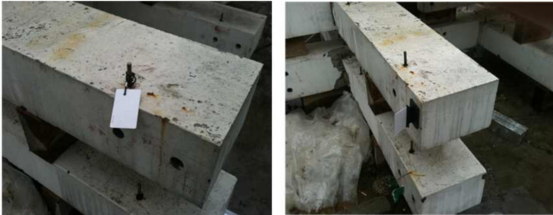
<그림 3-25> PC 부재 Tag 부착 위치
