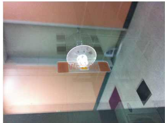
<그림 3-27> 커튼월 부재에의 Tag 부착 위치
