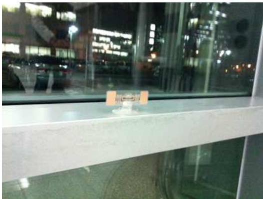
<그림 3-27> 커튼월 부재에의 Tag 부착 위치
