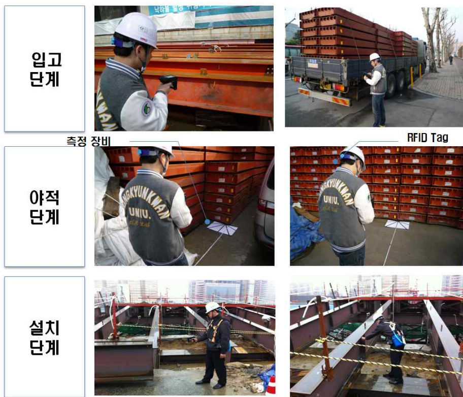
<그림 3-95> 철골 현장에서의 인식 테스트 모습
