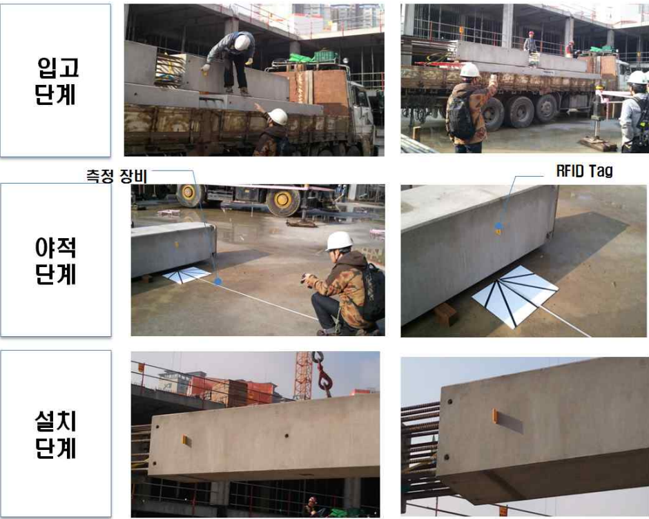
<그림 3-98> 스티커 타입의 현장 테스트 모습
