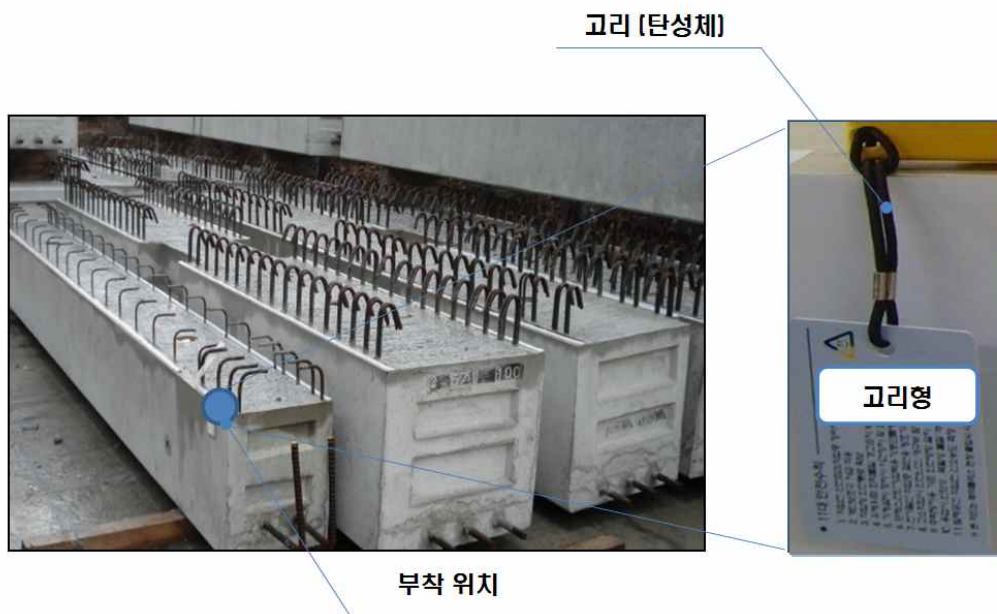
<그림 3-10> PC 부재를 위한 고리형 Tag Housing과 부착 방법
