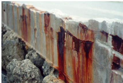
그림 1-2. 염소침투로 인한 해안지역 콘크리트 구조물의 철근부식 사례 9,10)
