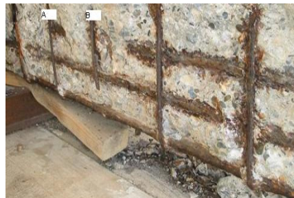
그림 1-2. 염소침투로 인한 해안지역 콘크리트 구조물의 철근부식 사례 9,10)
