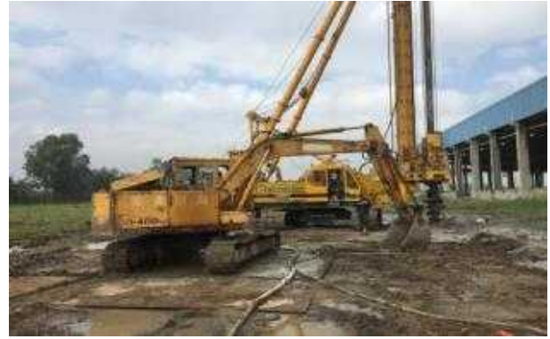
2) 장비이동 및 설치
