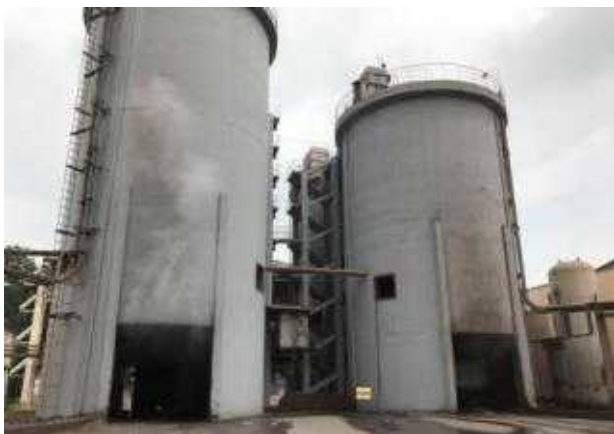
22) Cao Ngan Thermal Power Plant 사일로
