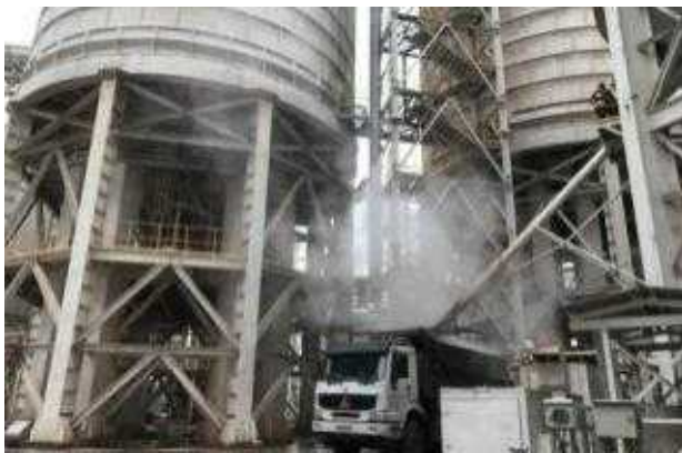
20) Mong Doung Thermal Power Plant 사일로
