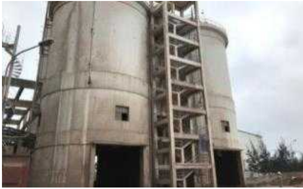
18) Cam Pha Thermal Power Plant 사일로
