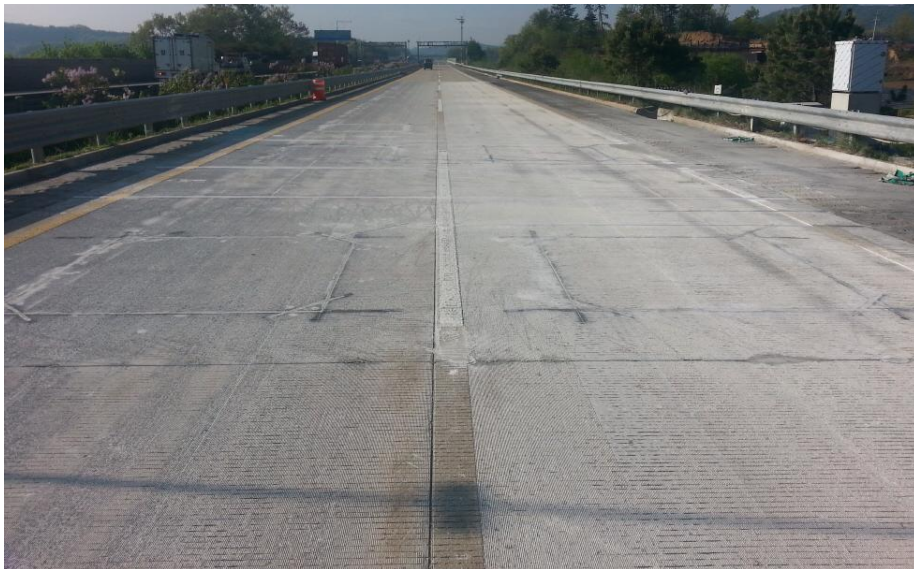
[그림 3.11] 피에조쿼츠 시스템 검지부 센서 설치 전경
