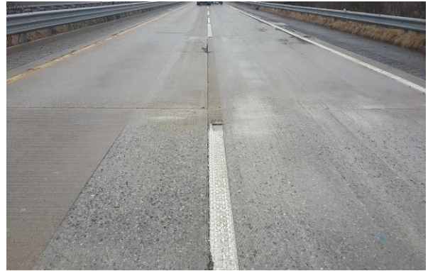
[그림 3.5] 노면 절삭 상태
